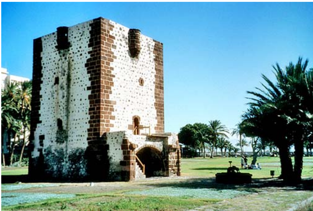
TORRE DEL CONDE
